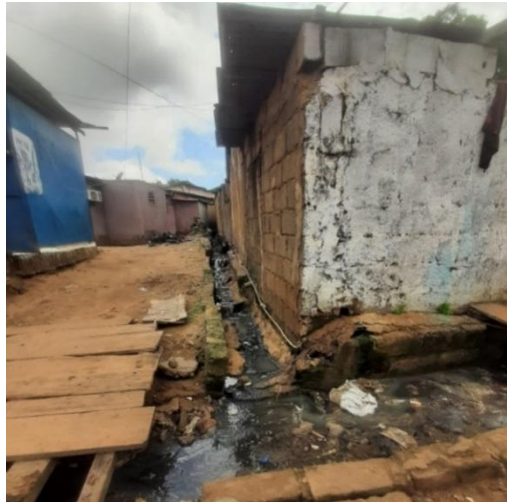
Photo 3 : Vue d'une habitation dégradée, entourée d'eaux usées domestiques
