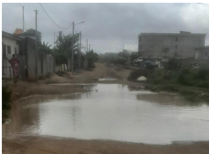
Photo 5 : vu d'une voie sur laquelle s'étale l'eau de ruissellement
