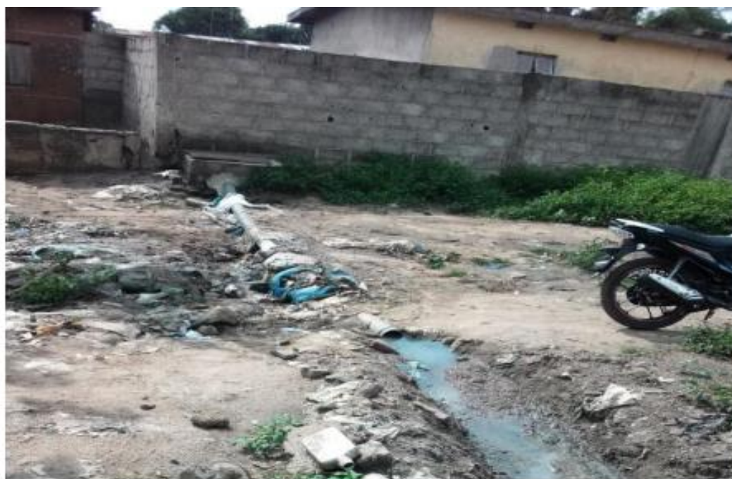
Image 2 : Canalisation des eaux usées quartier Dioulakro (Yamoussoukro)
