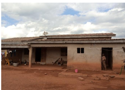
Figure 7. Résidence en cours d'achèvement
